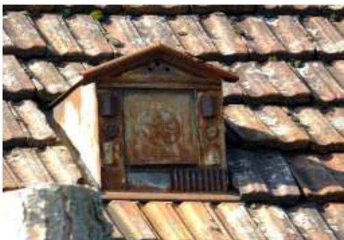
Példák bádgos munkára tetőszellőző és ereszelefolyók esetében.
