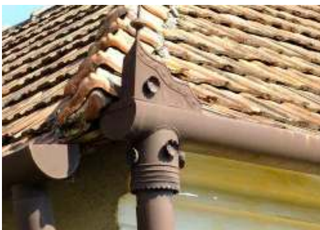
Példák bádgos munkára tetőszellőző és ereszelefolyók esetében.
